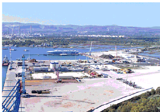
Il piazzali del porto di Augusta
